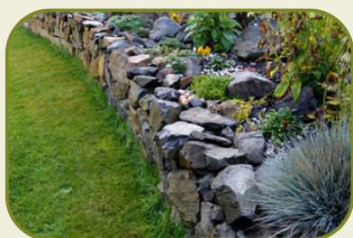
MURO DE PEDRA SECA
